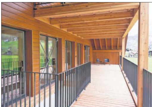
Der Balkon des Ferienhauses Alphorn ist neu gedeckt. PD
